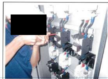
ตรวจเช็ค, ทดสอบ และบำรุงรักษาอุปกรณ์ต่างๆ ของระบบ Cap.Bank
