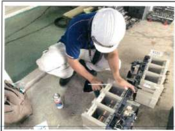
ตรวจเช็คทดสอบ และบำรุงรักษาหน้าสัมผัส และระบบกลไกต่างๆ ของ Main ACB.
