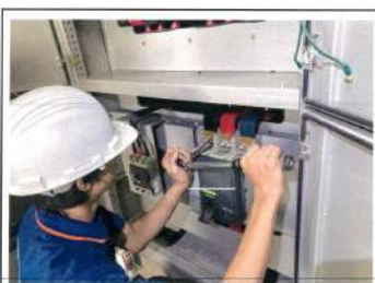
บำรุงรักษาและตรวจชิ้นส่วนกรู-น็อต Terminal Mainbusbar & Cable MCCB.ต่างๆ ในระบบฯ
