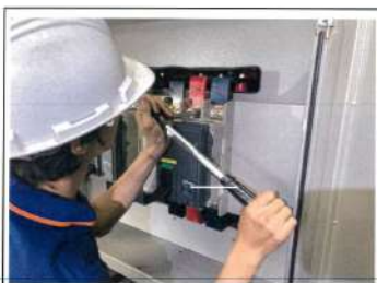
บำรุงรักษาและตรวจชิ้นส่วนกรู-น็อต Terminal Mainbusbar & Cable MCCB.ต่างๆ ในระบบฯ
