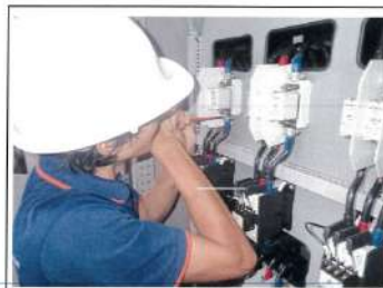
ตรวจเช็ค, ทดสอบ และบำรุงรักษาอุปกรณ์ต่างๆ ของระบบ Cap.Bank
