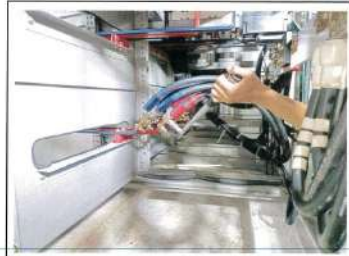
บำรุงรักษาและตรวจจันสกรู-น็อต Terminal Mainbusbar & Cable ต่าง ๆ ภายในตู้สวิตช์บอร์ด
