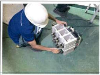
ตรวจเช็คทดสอบ และบำรุงรักษาหน้าสัมผัส และระบบกลไกต่างๆ ของ Main ACB.
